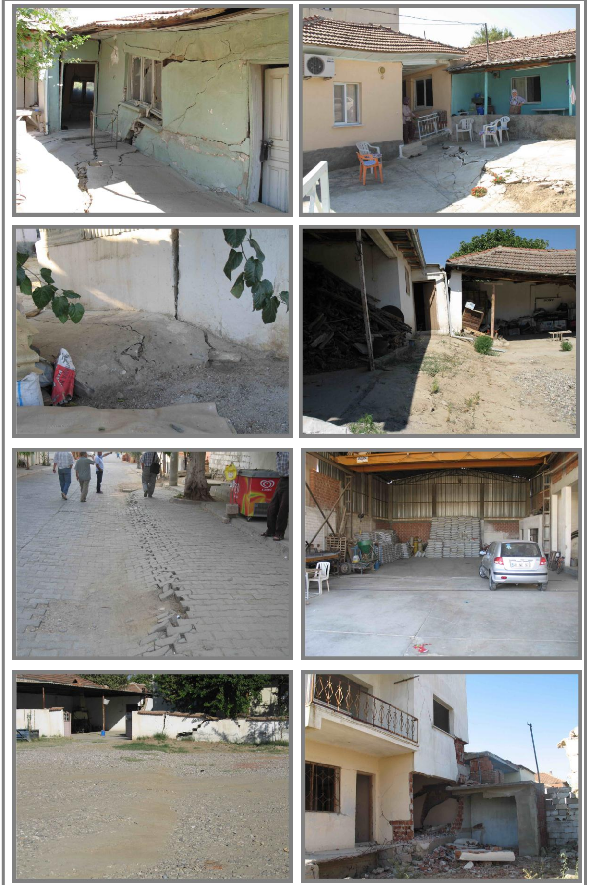
Şekil 11.12 Batıdan doğuya doğru, yüzey deformasyonları ve konut hasarı.
