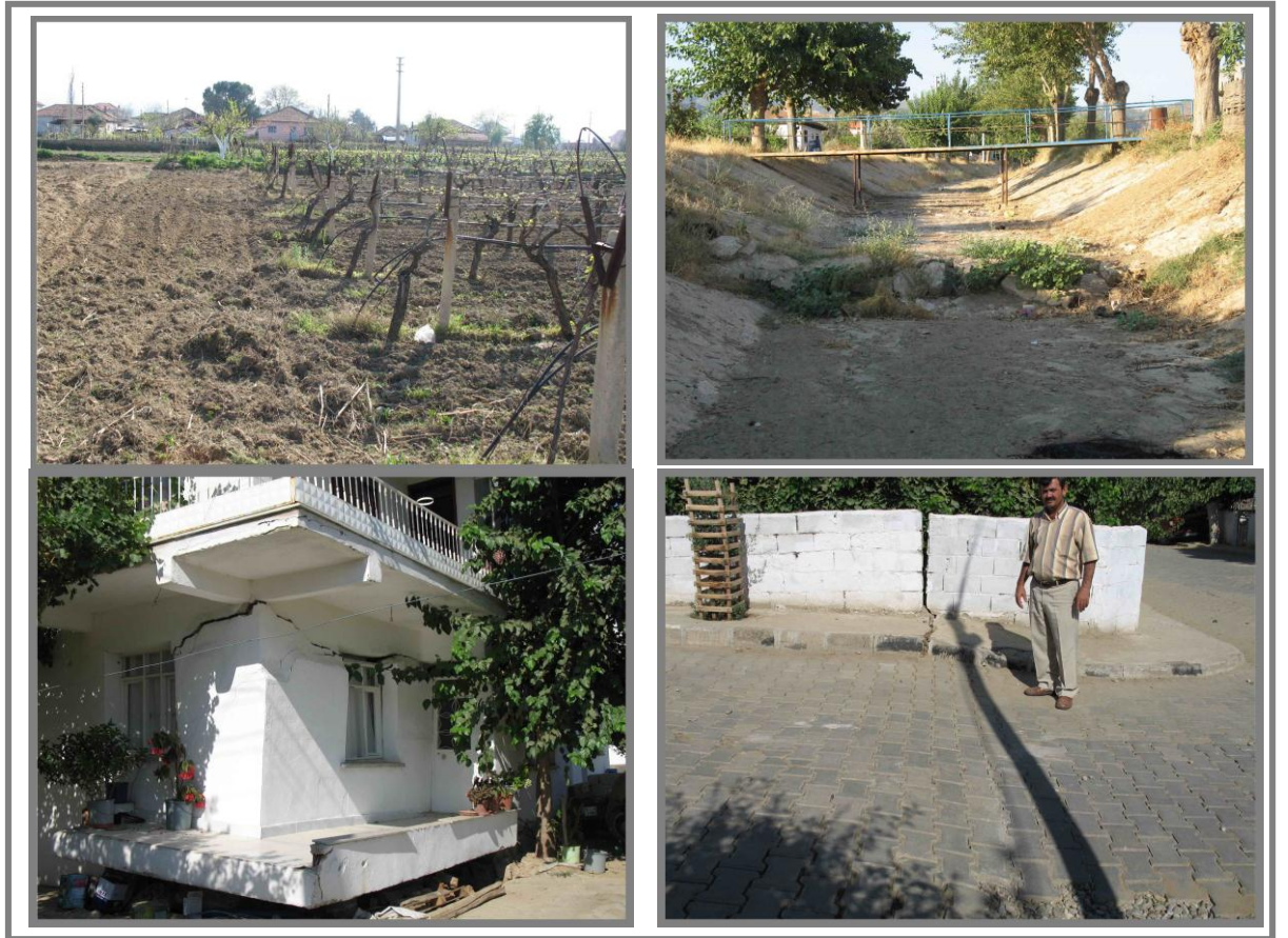
Şekil 11.12 Batıdan doğuya doğru, yüzey deformasyonları ve konut hasarı.
