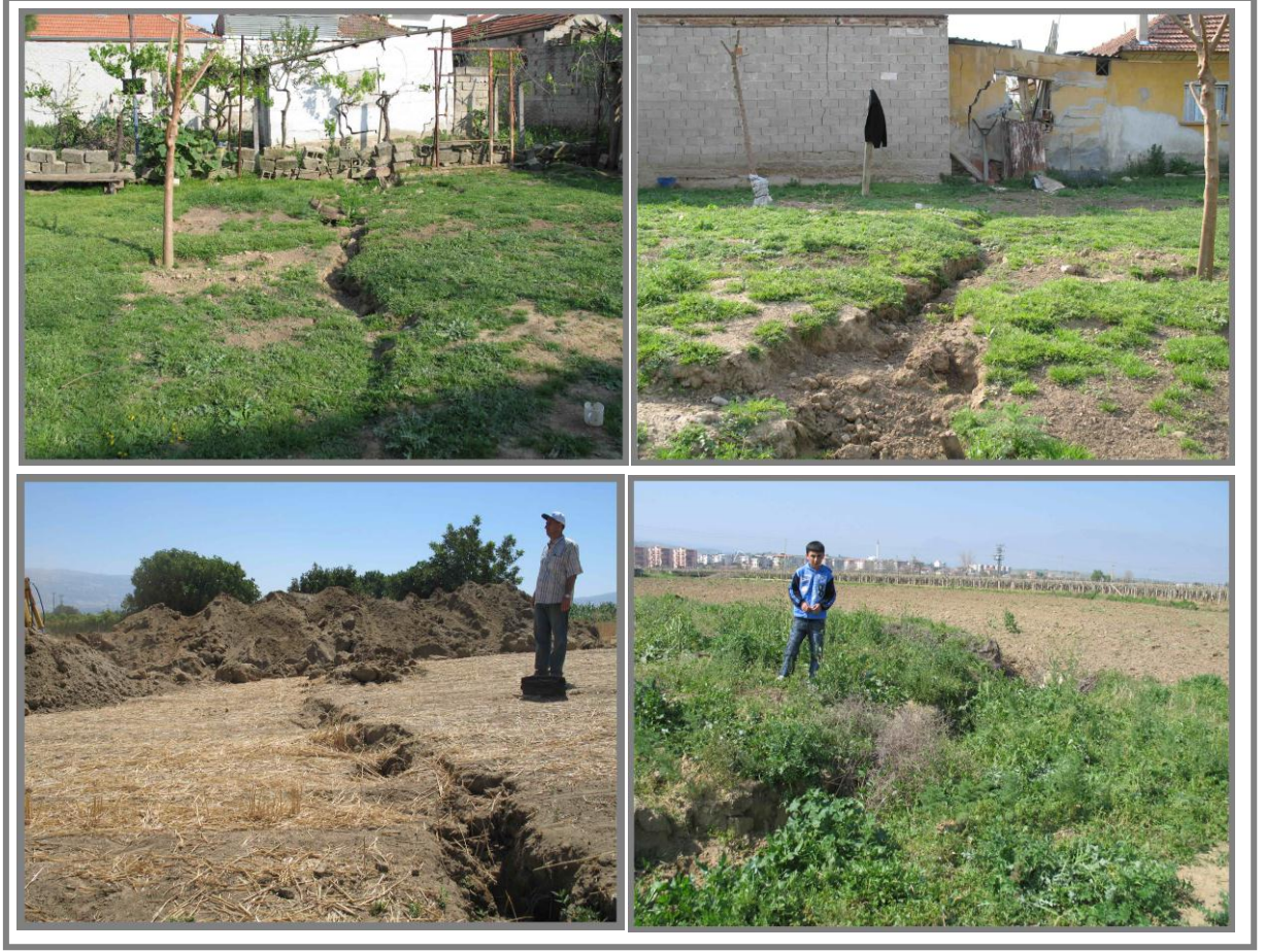
Şekil 11.13 Batıdan doğuya doğru, yüzey deformasyonları ve konut hasarı.
